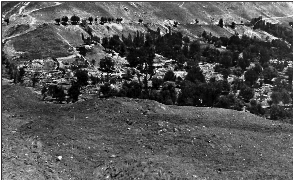
Развалины в северной части пос.Хаит. 1949 г. На переднем плане тыловая часть фронта каменно-земляного обвала. На заднем плане сохранившаяся часть трассы канала по правому борту долины р.Дарай-хаус.
